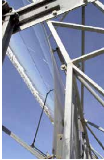
Şekil 2.19. 4 mm Kalınlığında CSP Aynası
